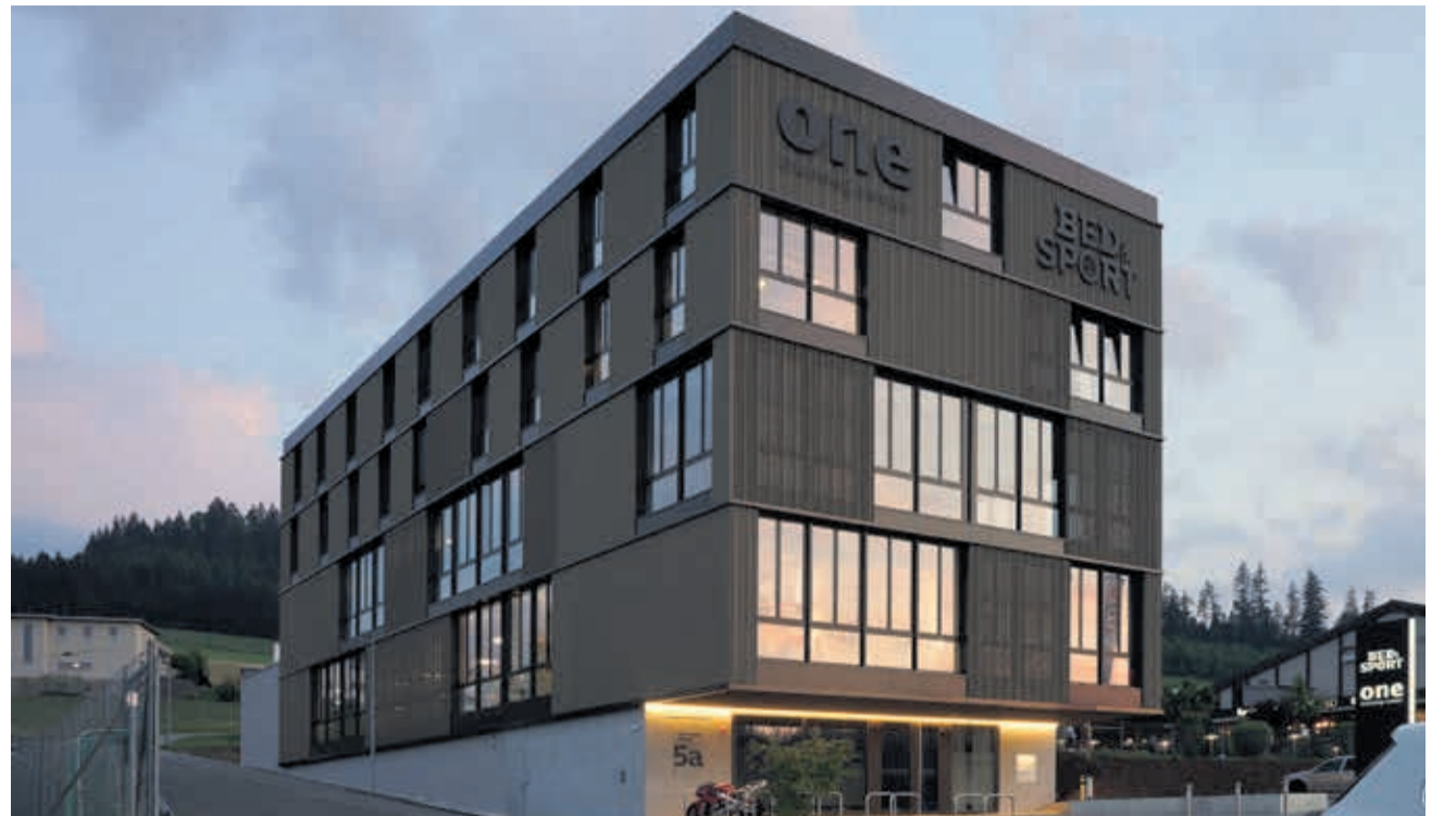
Aussenansicht vom Neubau. Fotos zvg
