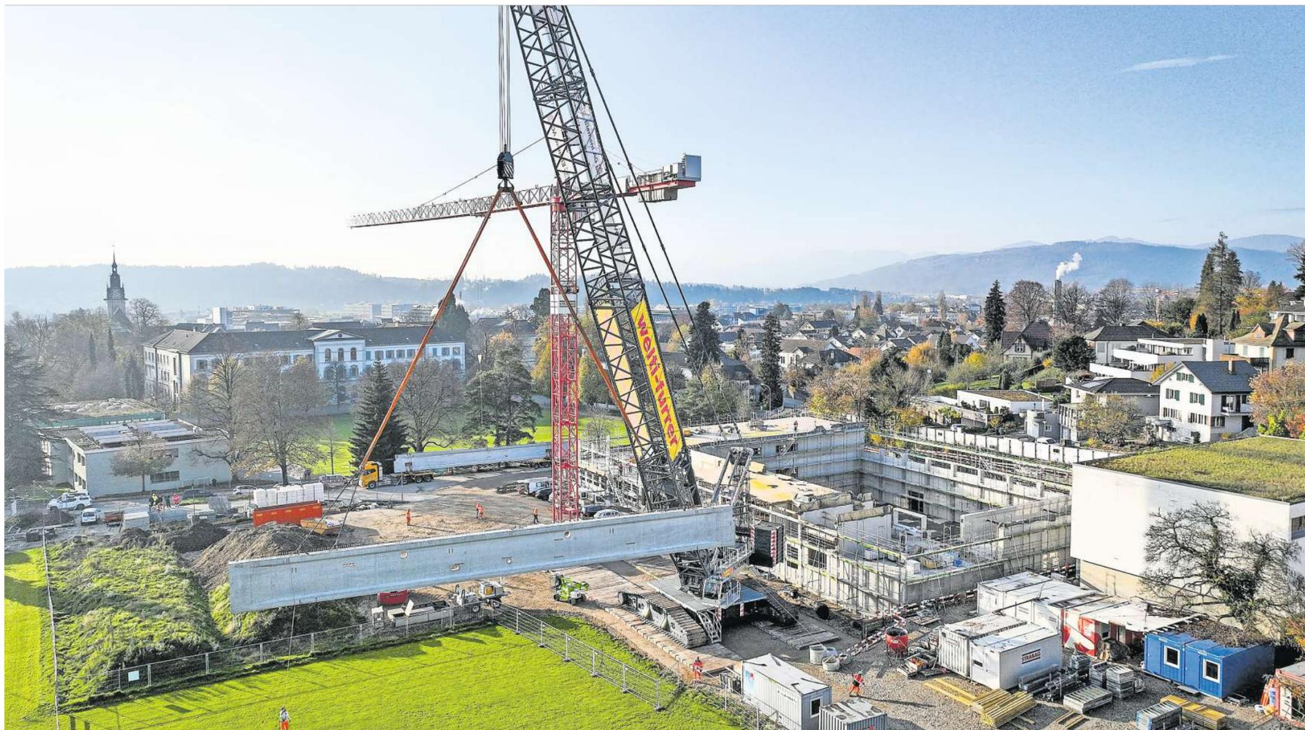
Am 15. und 18. November montierten Arbeiter zehn 60 Tonnen schwere Betonträger über der Dreifachturnhalle.
