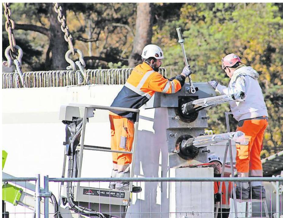
Zwei Bauarbeiter bereiten einen Betonträger für die Platzierung vor. Pro Träger nahm die Montage rund eine Stunde in Anspruch.
